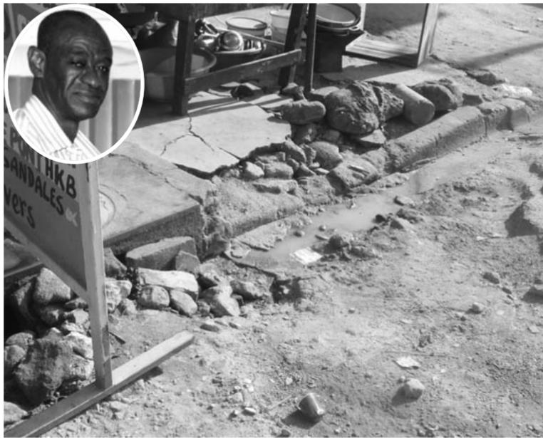
Les eaux usées constituées d'acide et de produits chimiques détériorent grandement le bitume.
