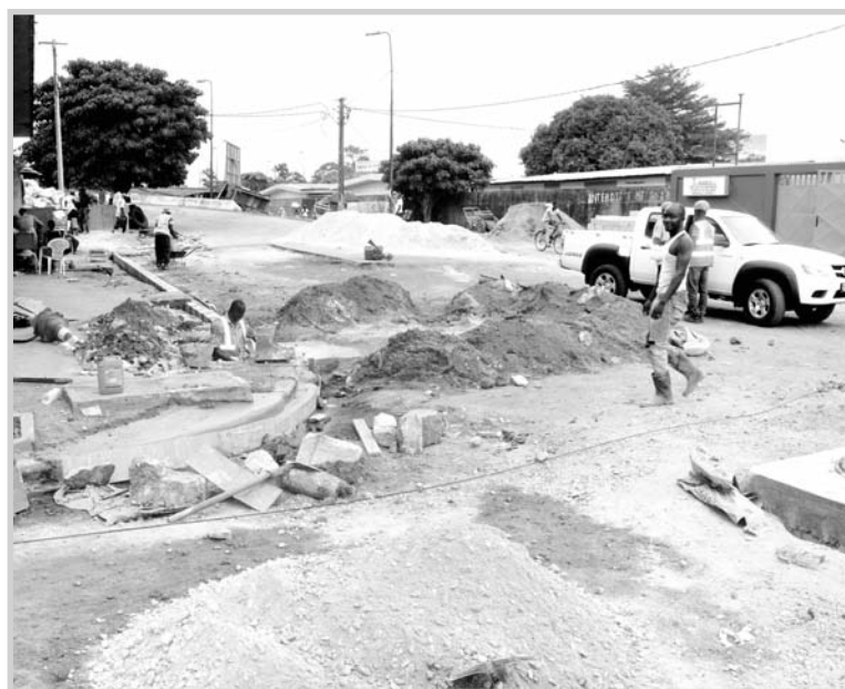
Travaux avenue 2 rue 21 (Photo d'archives).
