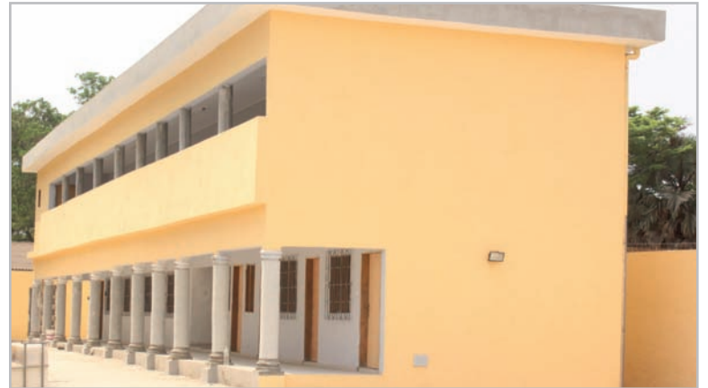
Voici les futurs locaux flambant neufs des enseignants du primaire de la commune.
